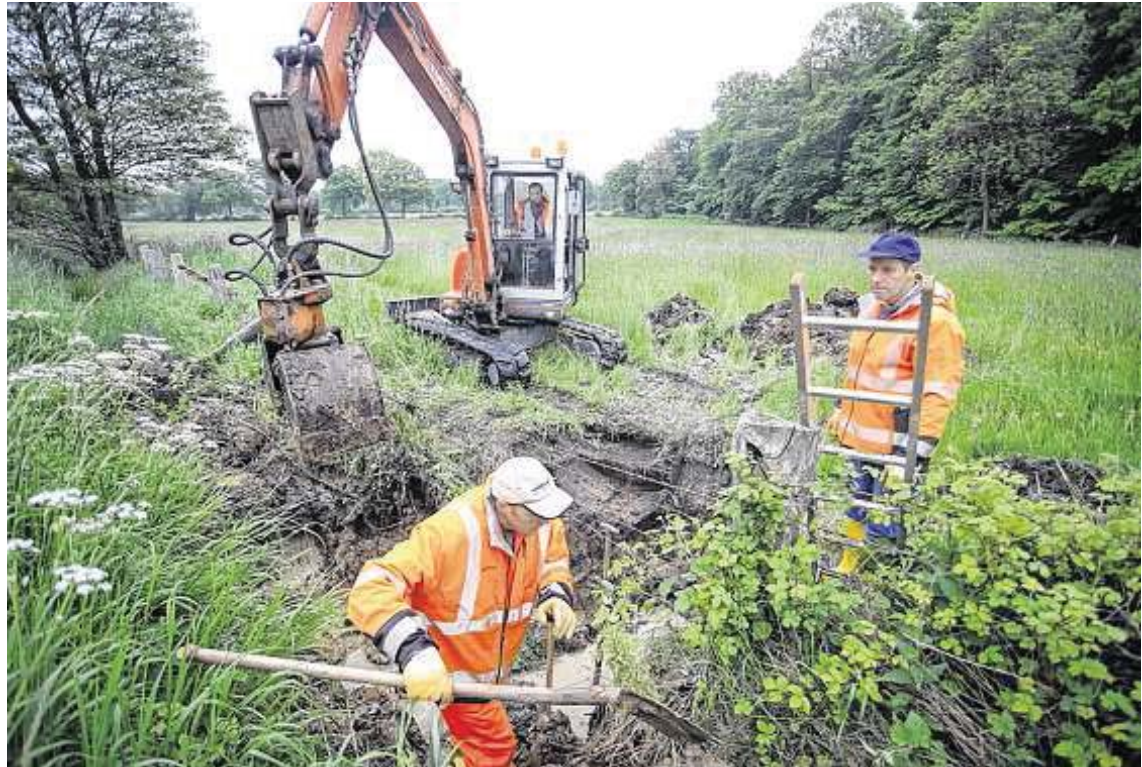
Ein Bagger arbeitet sich zur gebrochenen Rohrleitung vor die in 1,50 Meter Tiefe auf einer Wiese in Eggstedt verläuft. Seit Donnerstagmorgen laufen die Reparaturarbeiten. GKE - FOTO: CHRISTIAN KOSAK
