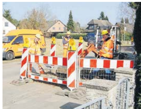
Die Mitarbeiter des Verbandes sind ständig in Sachen Wasserversorgung und Abwasserentsorgung im Einsatz. FOTOS: WAW
