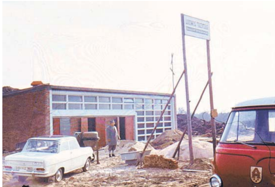
Auch dieses Kapitel gehört zur Geschichte des Wasser- und Abwasserverbandes: 1967 wurde auf dem Weyerberg eine große Trinkwasserbehälterstation errichtet. Später wurde der Bau mit Erde zugeschüttet – die Bergspitze wuchs dadurch vier Meter in die Höhe.
