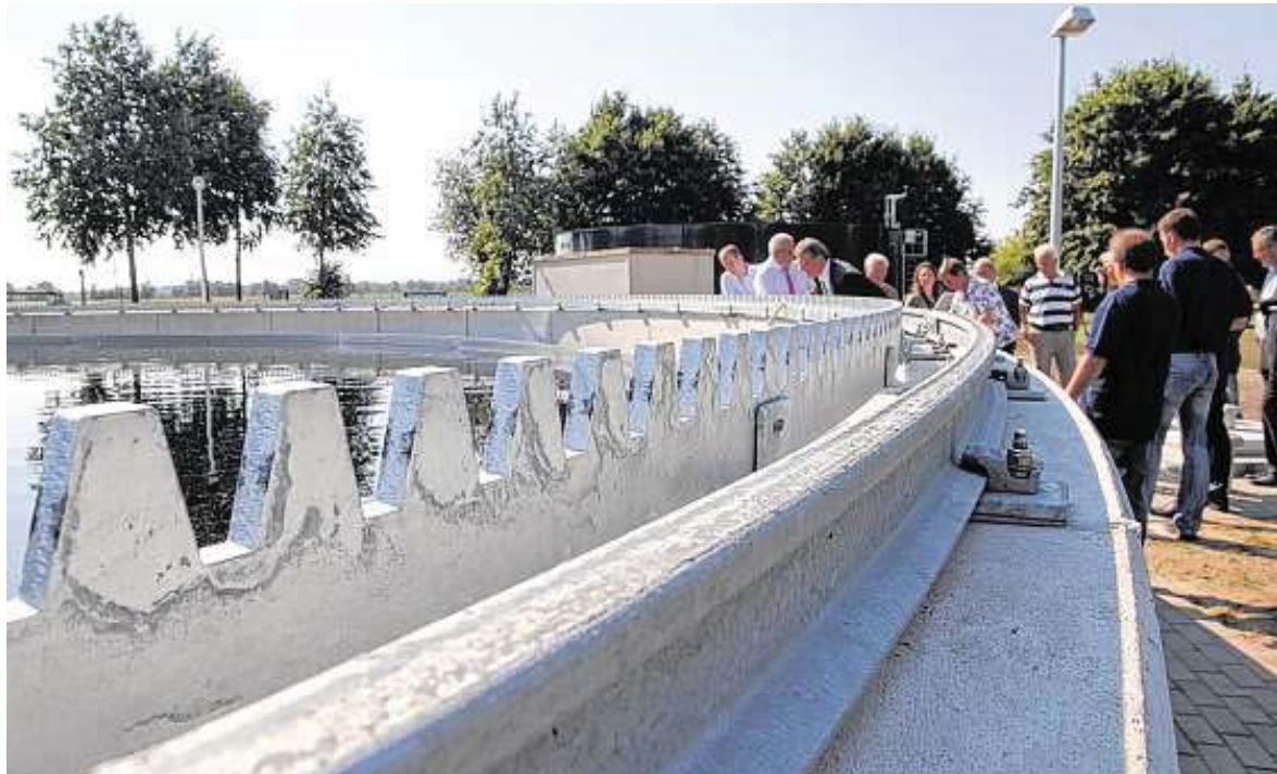
Bei der offiziellen Einweihung war ein Blick ins neue Nachklärbecken des Grasberger Klärwerks auch für die Gäste möglich.
