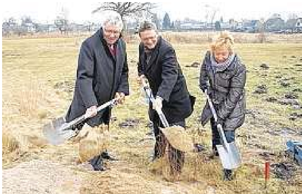
Spatenstich für das neue Baugebiet Neuenkirchen-Mitte: Gemeinde-Bürgermeister Harald Stehnken, Bernd Lütjen (Vorsitzender Wasser- und Abwasserverband Osterholz) und Neuenkirchens Ortsbürgermeisterin Annette von Wilcke-Brumund schippen Sand.
