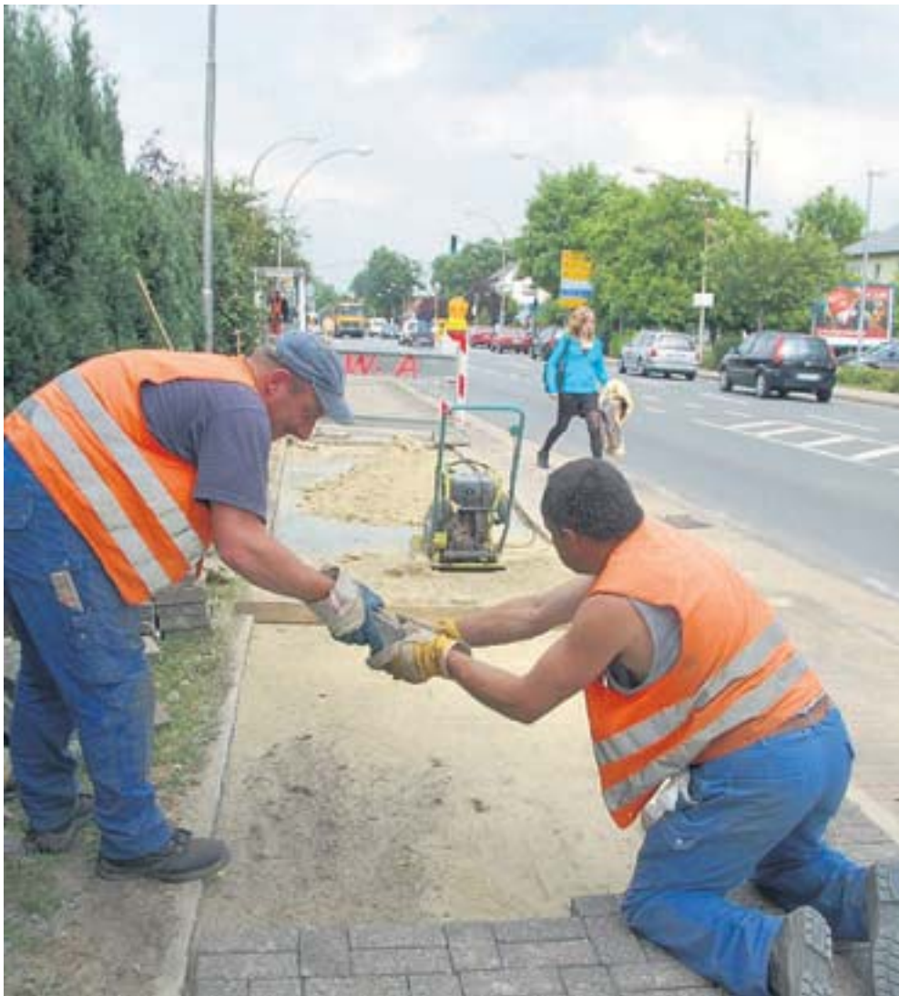
Sanierung der Trinkwasserleitung an der Blumenthaler Straße: Für weitere Bauabschnitte kommt es im Bereich der „Shell-Kreuzung“ zu Verkehrsbeschränkungen. FOTO: GABRIELA KELLER
