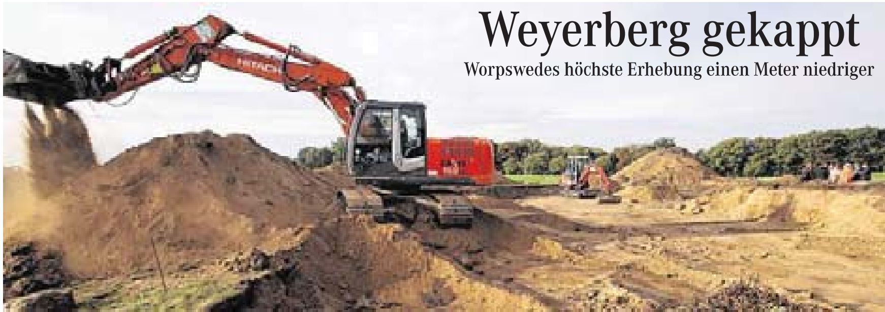
Bewegter Gipfel: Auf dem Weyerberg in Worpswede werden derzeit 750 Kubikmeter Sand und Erdreich weggebaggert.
