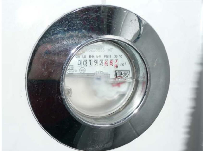
Trockenläufer sind solche, bei denen nur die Messflügel und die Übersetzungsgetriebe im Wasser liegen, während das Zählwerk im dicht abgeschlossenen Trockenraum durch eine Magnetkupplung angetrieben wird.
