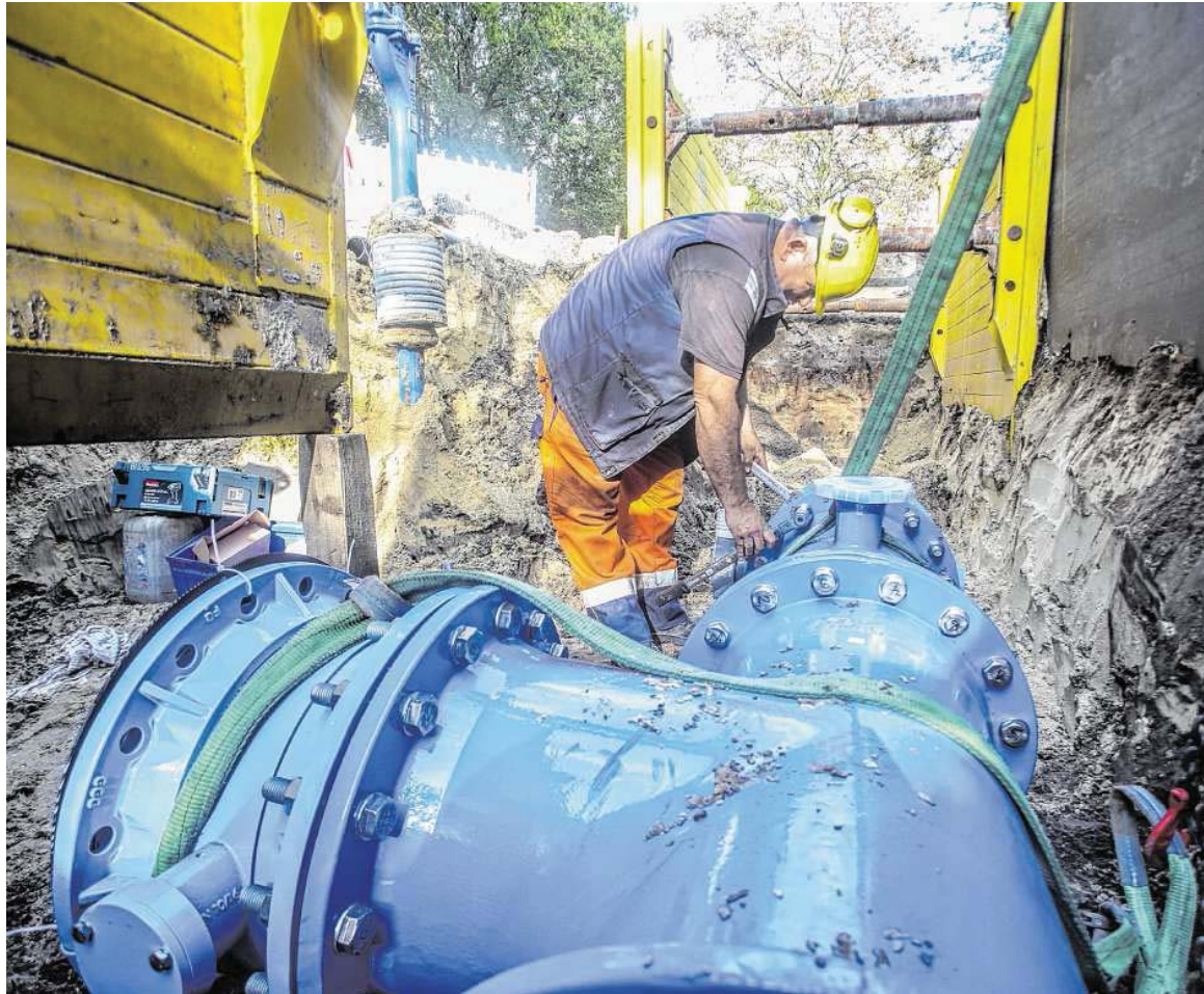
In der Baugrube an der Landesstraße 134 werden die Vorbereitungen getroffen für die Netzanbindung der neuen Leitung.
