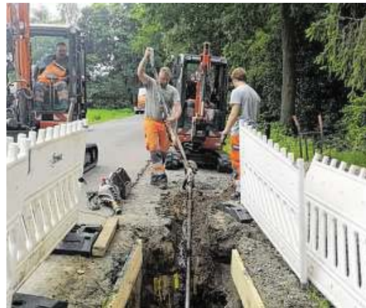
Im Bohrverfahren wird die neue Trinkwasserleitung verlegt.
