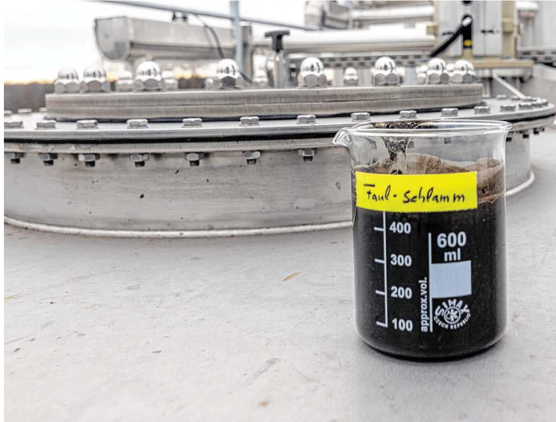
Der Faulprozess wird in regelmäßigen Abständen über einen Zugang auf dem Dach des Faulturms geprüft.
